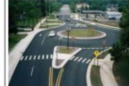
Пешеходные переходы с островками безопасности
