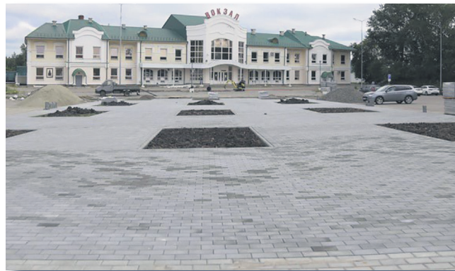
Ремонт привокзальной площади и фасада здания.
