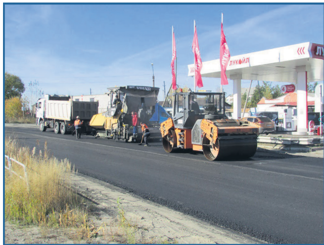
Ремонт дороги по улице Ленина.
