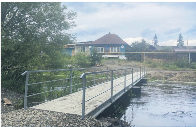
Ремонт моста на улице Серикова.
