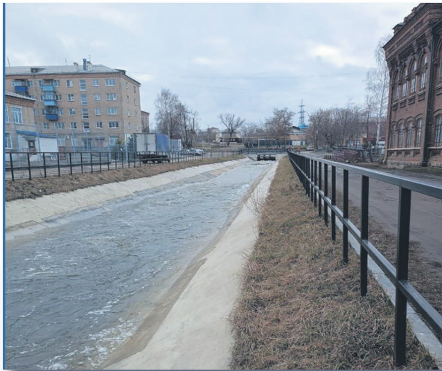
Северный водосбор ГТС справился с обильным паводком 2024 года.
