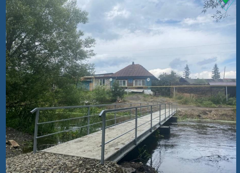
Капитальный ремонт пешеходного моста по улице Серикова
