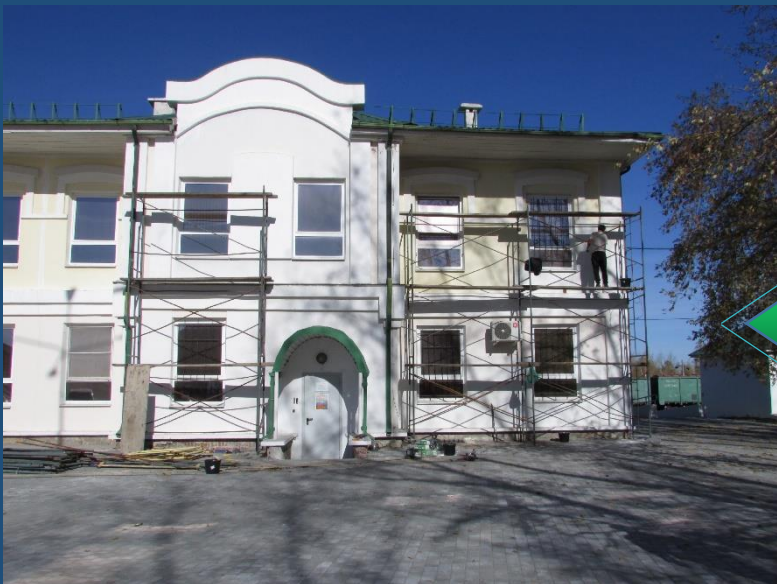
Ремонт здания вокзала
