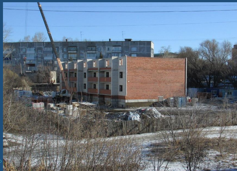
2025 год: строительство домов на улицах Ленина, Калинина, Вайнера (15160 кв. метров)
