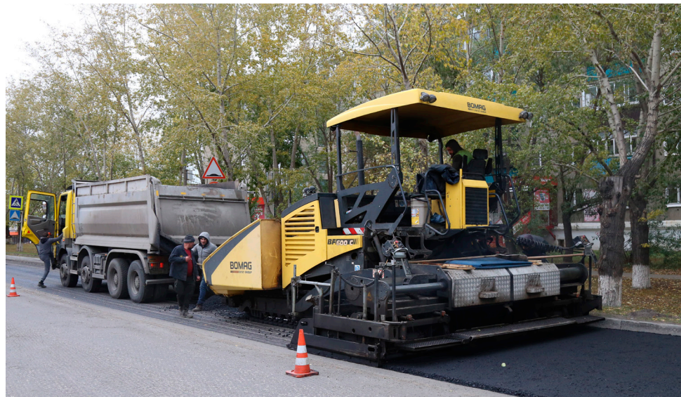
Осенью выполнен первый этап ремонта дороги на улице К. Либкнехта.
