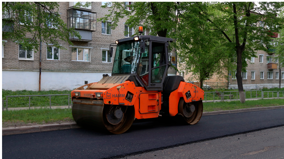
В 2021 году капитально отремонтировано более 2 км дорожного полотна на улице Республики.
